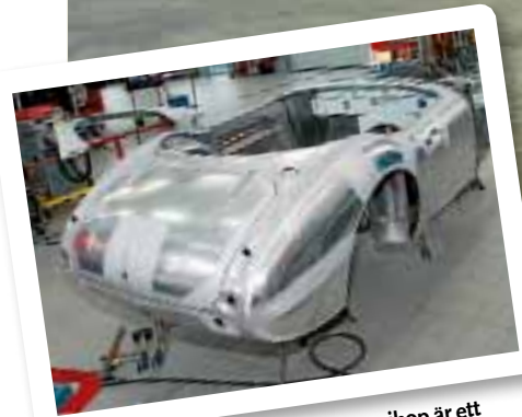
Att få nytillverkade delar att passa ihop är ett tålmodskrävande arbete.
